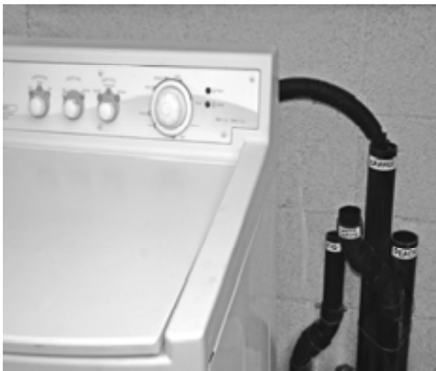
الشكل 26.4. يتم تصريف المياه الرمادية (تحمل علامة الوجهة: تين، ووايت سابوت، وبرتقال، وخوخ) بجانب الغسالة الكهربائية. ويوضع خرطوم التصريف من الغسالة في أنبوب مختلف مع كل دفعة غسيل. والخيار لعائلة تستعمل المنظفات غير المتوافقة حيويًا هو إدراج أنبوب تصريف إضافي عليه علامة يصرف الماء إلى مجرى تصريف.
