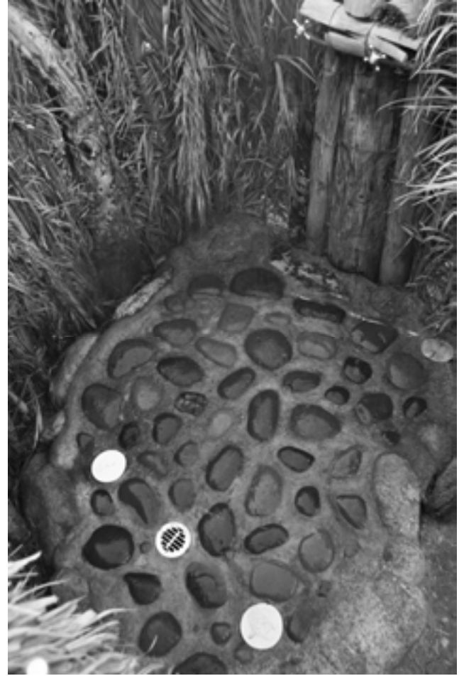
الشكل 30.4. ثلاثة مصارف على الجزء السفلي من دش استحمام خارجي، كل منها يحول المياه الرمادية إلى نباتات مختلفة في الموقع الخارجي.
