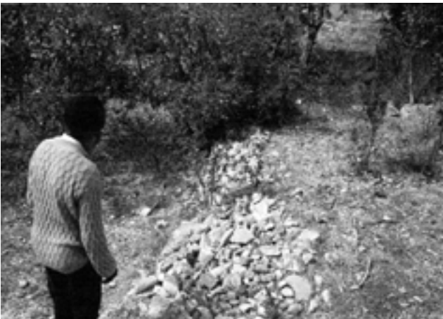
الشكل 5.1، سد كابح من الحجارة السائبة عالج أخدوداً كان يسبب التعرية فيما مضى
