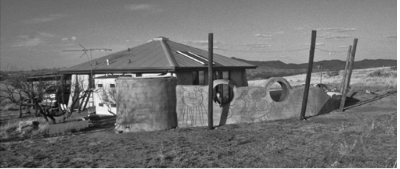
الشكل 13.4. مشهد من جهة الرياح السائدة لخزان وجدار ألبيغرا الكويست اللذين يشكلان مصيدة وقائية لأشعة الشمس ومصد رياح لفنائها. الألواح الشمسية على السقف تواجه الجنوب.
