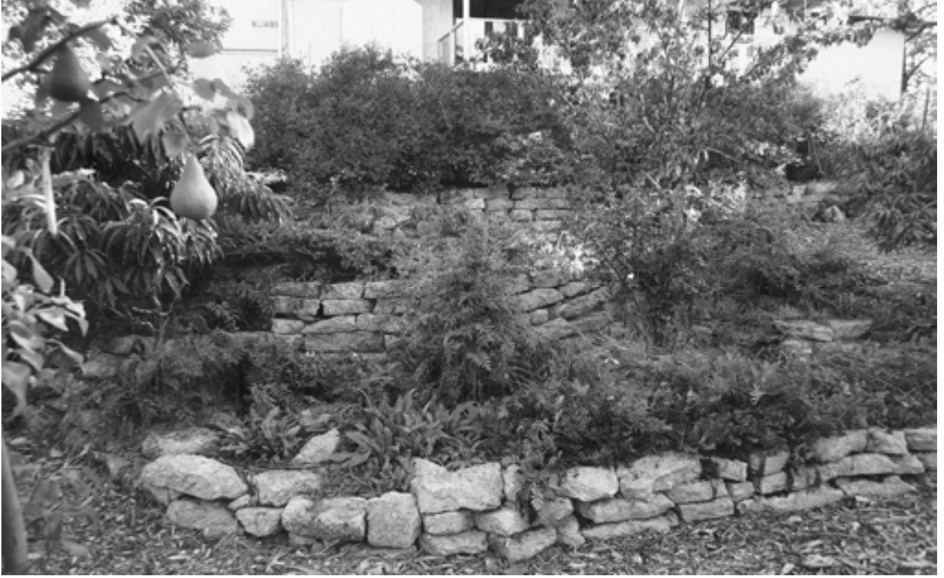
الشكل 5.3. مصاطب مثبتة بجدران استنادية مصنوعة من بقايا صخرية في الفناء المنحدر في سكن زيماش في لوس ألاموس في نيو ولاية ميكسيكو. لرؤية الصورة ملونة أنظر الغلاف الخلفي من الداخل.
