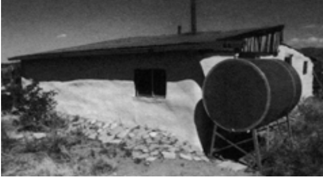
الشكل 38.3. منزل الزوجين هاول وخزانها الذي يتسع لـ 500 غالون (1,895 لتراً) والمصنوع من الفولاذ المغلفن
