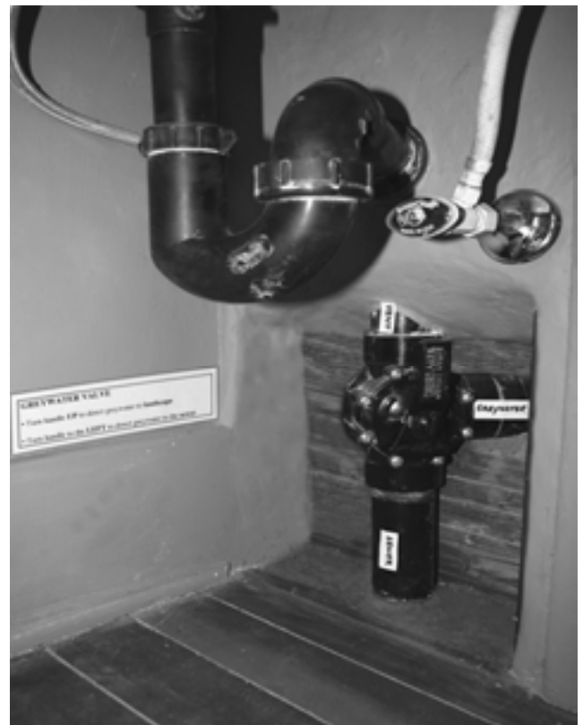
الشكل 25.4. صمام مجوّل ثلاثي الاتجاهات تحت المغسلة يعطينا الخيار الملائم لإرسال المياه الرمادية إلى الموقع الخارجي أو إلى مجرى تصريف بناء على ما الذي يمر في المصرف.
